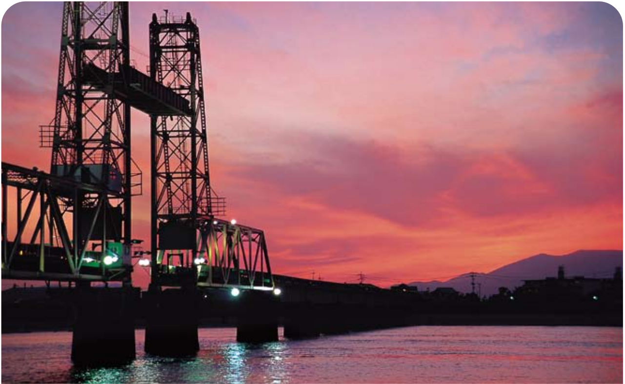
■諸富町 昇開橋
