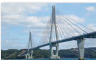
鷹島肥前大橋
